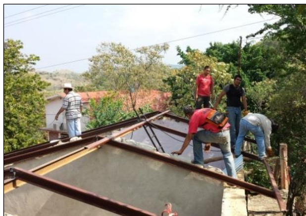
Durante los trabajos de uno de los techos.
