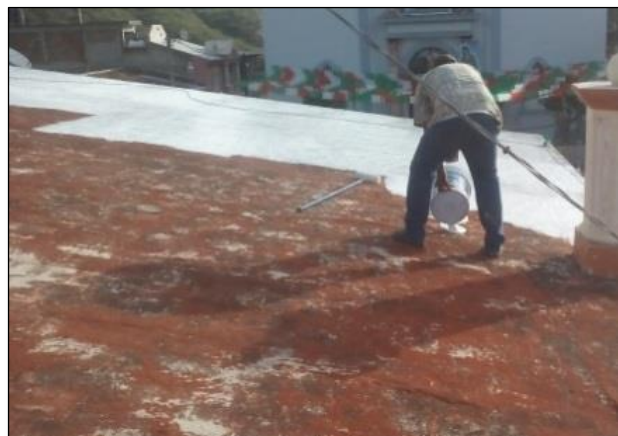
Durante los trabajos de la obra.
