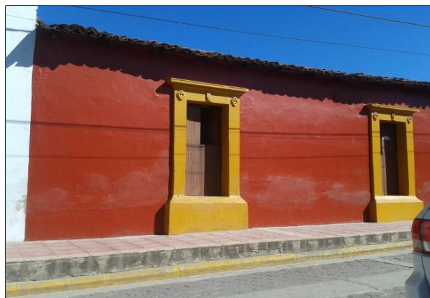
Después de la obra.
