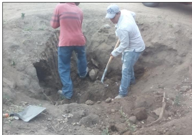
Al inicio de la obra.
