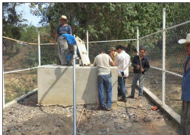
Durante la sustitución de bomba de agua.
