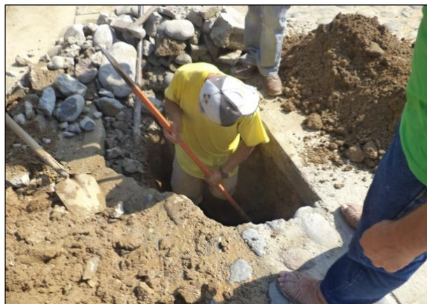
Reparación de fuga de agua rumbo al panteón.
