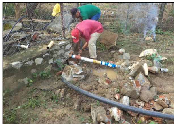
Conexión de tubo de 18 metros para evitar cortar el suministro de agua.
