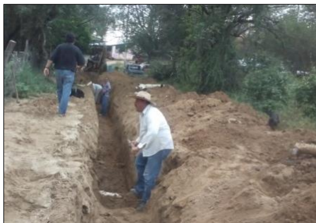
Durante los trabajos de la obra.
