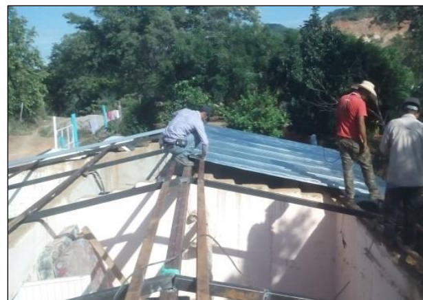
Colocando las láminas.
