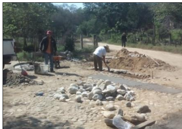
Finiquitando los trabajos de la obra.
