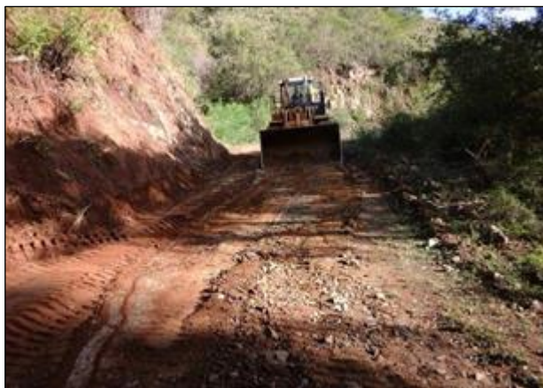
Camino a “Los Nogales” durante su rehabilitación.
