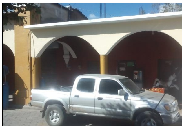
Después de la obra.
