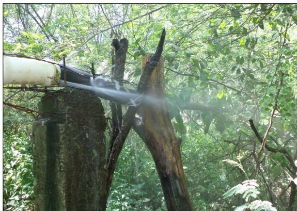
Reparación del tubo de agua potable en la comunidad De "El Terrero" (En la foto: Fuga)
