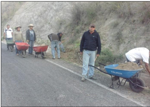
Personal limpiando los bordes de la carretera y canaletas de desagüe.
