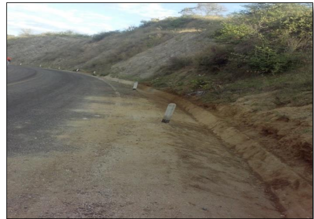
Así quedó. Se puede apreciar el vestigio de la mancha de tierra que cubría algunas partes de la carretera.
