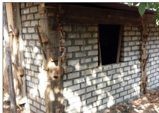
El muro ya terminado de una de dos obras.
