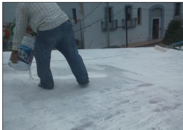
Culminando la obra.
