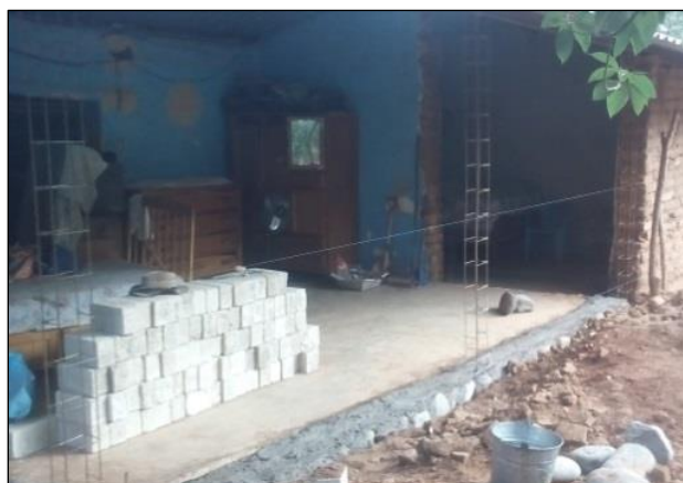
En 2 casos muy específicos se adicionó un muro.
