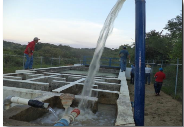
Durante la revisión del estado situacional.
